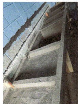
Foto 4: Levantado de muros, columnas de lavadero y tallado final de pila para el nivel Párvulos.
