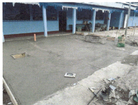
Foto 2: Fundición área de losa de patio del nivel Párvulos.
