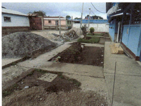
Foto 1: Demolición, relleno e instalación de línea de drenaje de ara de losa de patio del nivel de Párvulos
