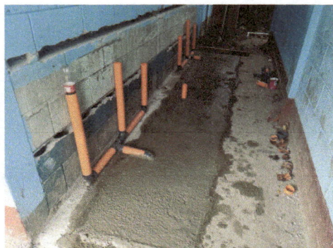
Foto 3: Instalación de línea de drenaje y fundición y armado de base de pila del nivel Párvulos.
