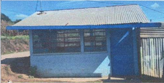
Foto 1: Mejoramiento de Cocina
