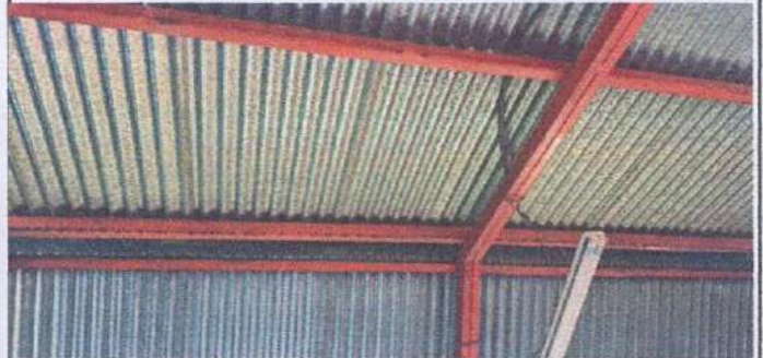
Foto 2: Instalación de Energía eléctrica
