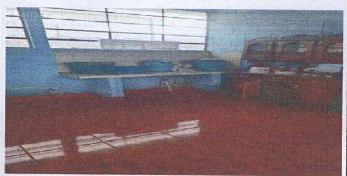
Foto 8: Sustitución de piso de cocina y corredor
