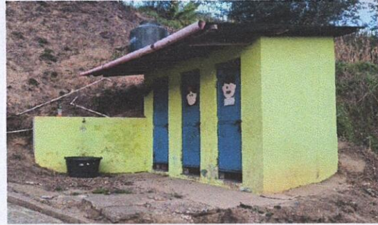
Foto 2: Remodelación y ampliación de sanitarios.
