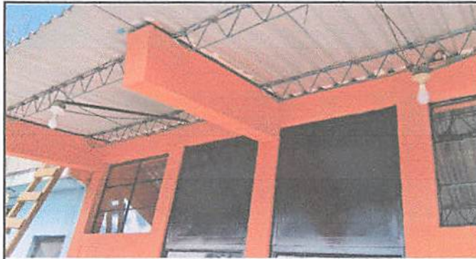
Instalación de iluminación a los sanitarios
