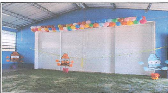
Instalación de puerta corrediza para división de aulas
