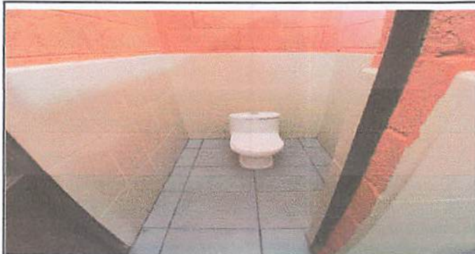
Instalación de Servicios sanitarios para niños y niñas.
