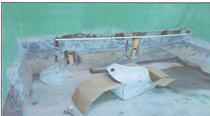
Demolicion de lavamanos y mingitorios e instalación
