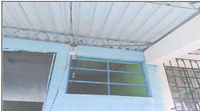
Instalación de iluminación a los sanitarios
