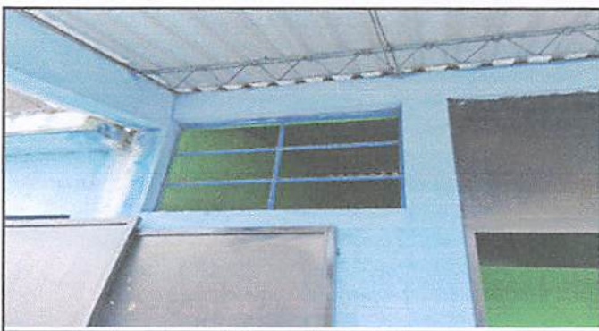
Reparación de ventanas, pintar y cambio de vidrio
