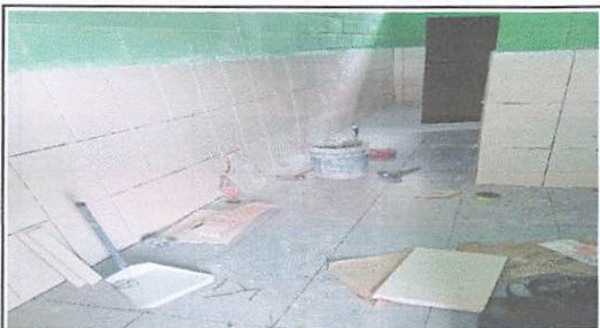
Aplicación de pintura y azulejo a las paredes de los sanitarios
