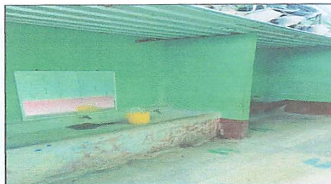
Demolición de lavamanos y mingitorios e instalación
