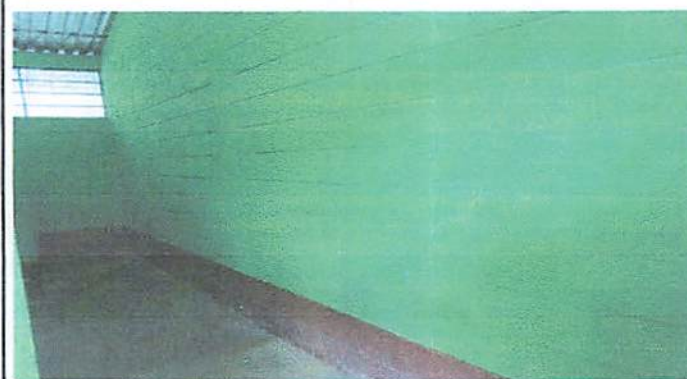
Aplicación de pintura a las paredes de los sanitarios
