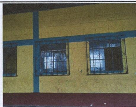
Foto 6: Pintura de Aulas
