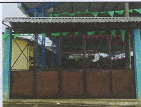
Foto 5: Cambio de Chapa
