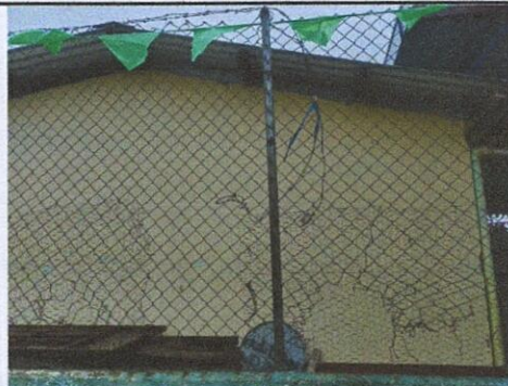
Foto 2: Cambio de Malla
