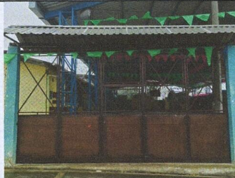
Foto 4: Reparación y Pintura de Porton
