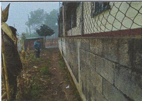
Foto 1: Reparación de Muro de Contención
