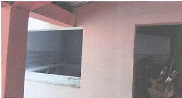
Foto3: ventana terminada con su azulejo.
