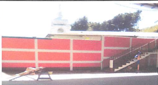
Foto 1 : Finalizacion de aplicación de pintura en paredes de la escuela.
