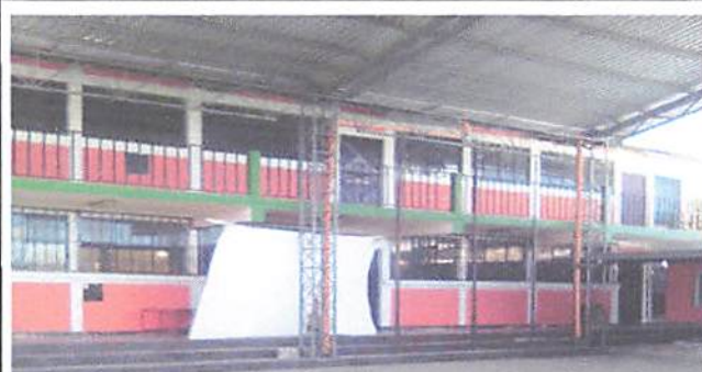
Foto 4: Finalizacion de Aplicación de pintura en segundo nivel .
