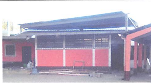
Foto : Finalizacion de aplicación de pintura en paredes de el aula de preprimaria.
