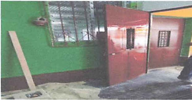
Foto 1 : Puerta de ingreso terminada y colocada en su lugar
