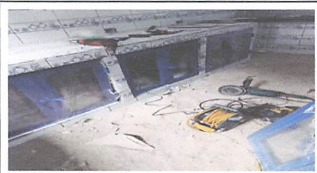
Foto4: Puertas de gabinetes segundo tramo terminado
