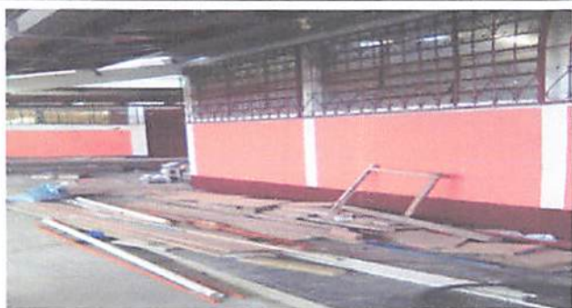
Foto 3: Finalizacion de la aplicación de pintura en paredes .
