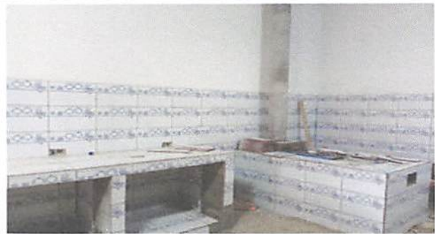
Foto :2 Finalizacion de poyo colocacion de ceramica.
