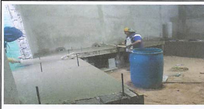
Foto 6 : Levantado e intalacion de gabinetes de cemento 4 metros con azulejo
