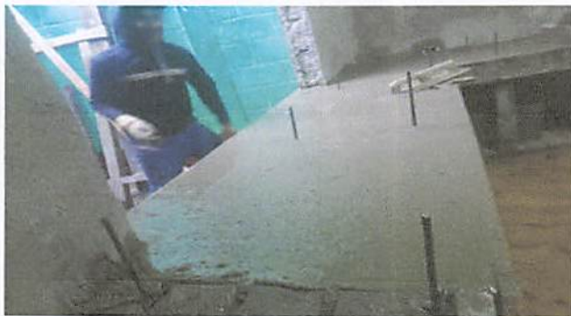
Foto7: Levantado de gabinetes , fundicion de losa y ampliacion de ventana
