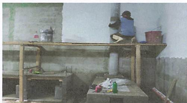
Foto 4: Repello y blanqueado de paredes
