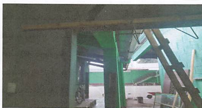
Foto 9: ampliacion de puerta y ventanal.
