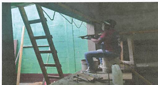
Foto 8: Ampliacion de puerta y ventana tallado de columnas.
