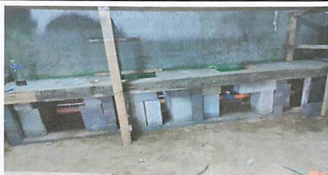
Foto 5 : Levantado e instalacin de lava trastos 4 metros.
