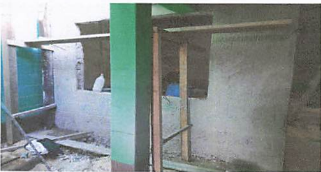
Foto 11. Ampliacion de puerta y ventana .
