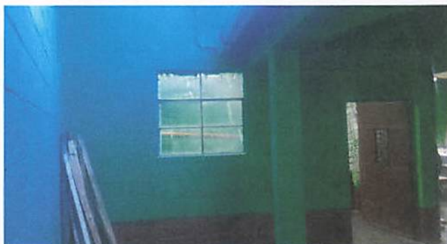
Foto 4 remodelacion de ventanal 225x125cms remodelacion de de puerta 100x215 cms
