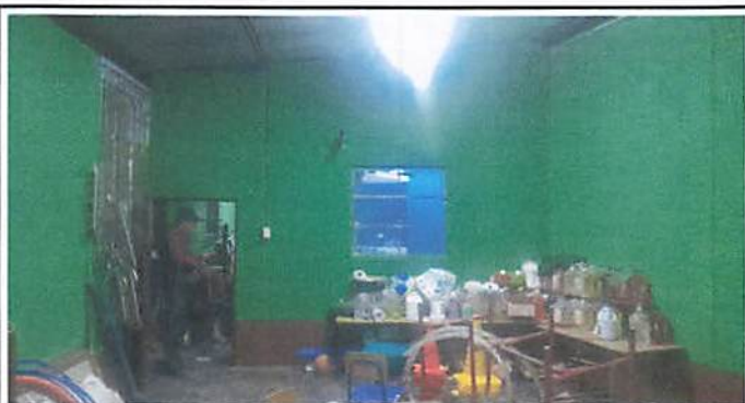
Foto 3 Area de remodelacion comedor, remodelacion de puerta 100x 215 cms, remodelacion de ventanal de 225x125 cms, gabinetes de cemento y puertas de metal doble de 40x90 cms, azulejo en paredes, y gabinetes
