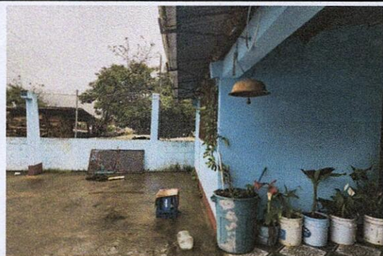
Foto 4: Pintura de las instalaciones del establecimiento.
