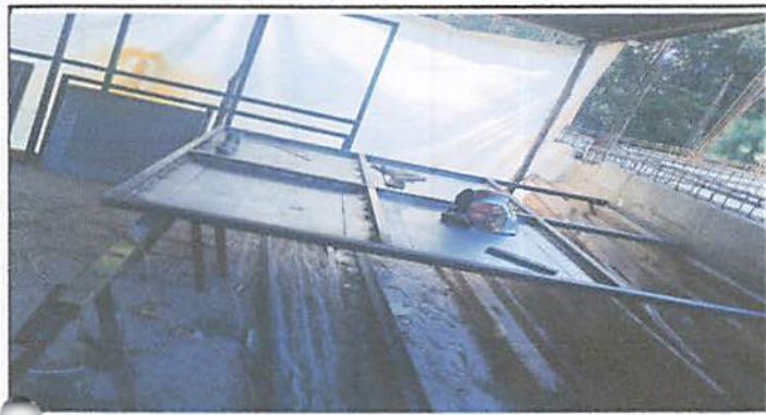
FOTO 1: ESTÁ FABRICANDO EL PORTON CON MATERIALES ADECUADOS A LA NECESIDAD
