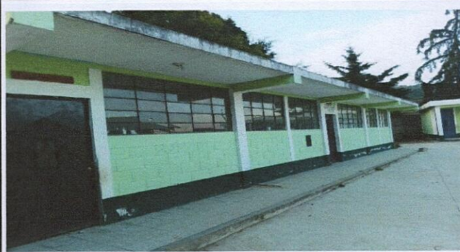
colocación de balcones a ventanas de aulas
