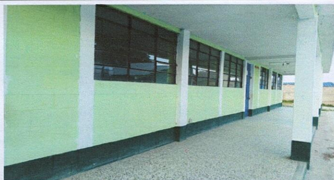
Colocación de balcones a ventanas de aulas
