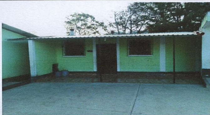
Ampliación y remodelación de la cocina
