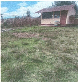
Foto 3. Construcción de losa de patio
