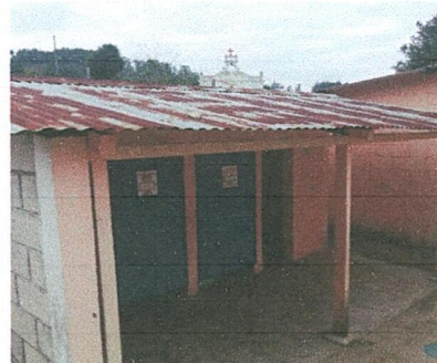
Foto 4. Reparación de Sanitarios
