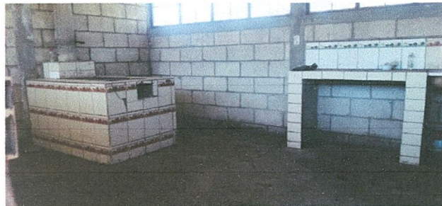
Foto 2. Remodelación y construcción de dos poyos, cambio de plancha y chimenea.
