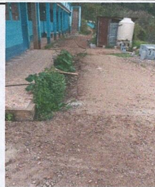
Foto 2: Pavimentación ingreso a aulas modulo 2
