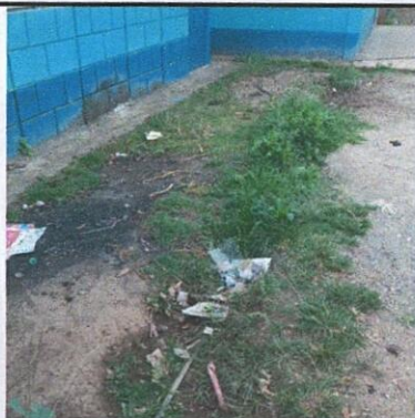
Foto 3: Cunetas frente a cocina y aulas
