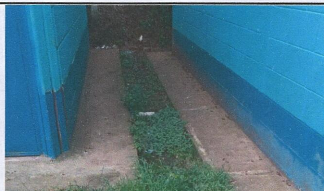
foto 4: Cunetas de concreto
