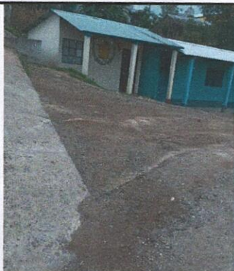
Foto 1: Pavimentación ingreso a modulo 2
