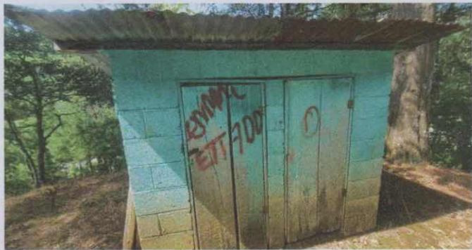
Remodelación y ampliación de sanitarios y pozo séptico
