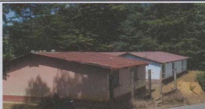
Sustitución y cambio de techado de aula, bodega y corredor
