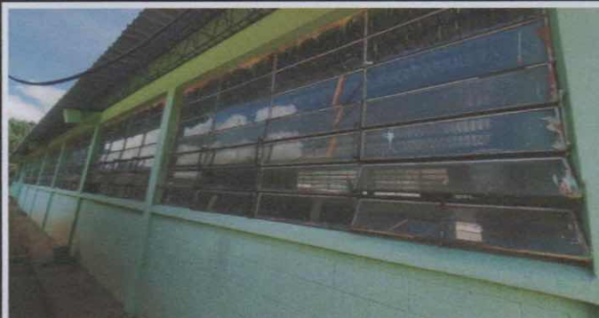
Colocación de balcones, pintada de estructura metálica de ventanas y sustitución de vidrios de 4 aulas y dirección.
