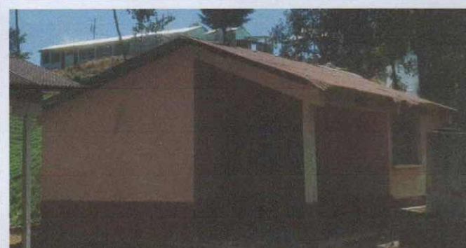
Pintura de aula y bodega
