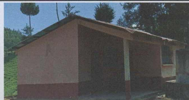
Pintada de puertas y balcon de aula y bodega
