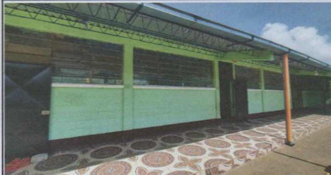
Pintada de estructura metálica y sustitución de vidrios de las ventanas de 4 aulas y dirección
