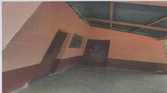
Sustitución de torta de cemento a cerámica de 1 aula, bodega y corredor
