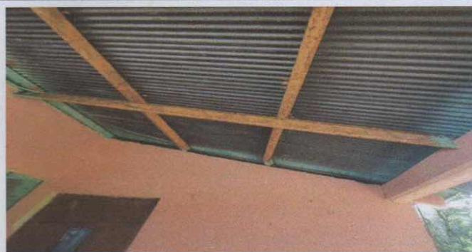
Reparación de energía eléctrica de 1 aula, bodega y corredor
