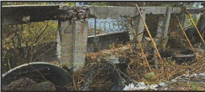
REPARACIÓN DE MURO DE CONTENCIÓN
