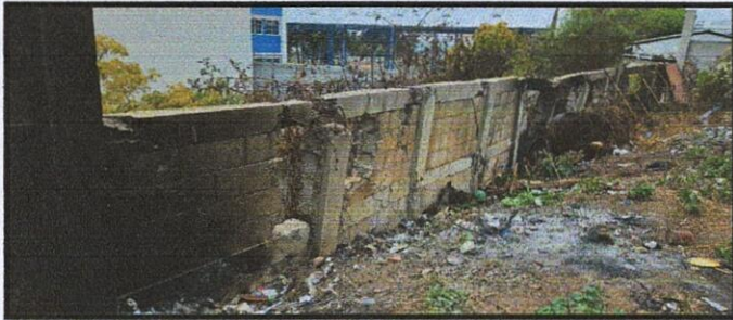
REPARACIÓN DE MURO DE CONTENCIÓN
