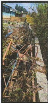
REPARACIÓN DE MURO DE CONTENCIÓN
