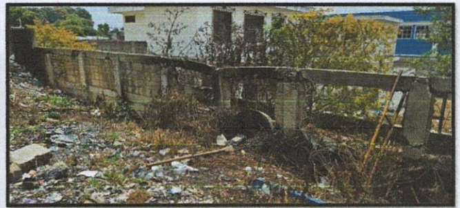
REPARACIÓN DE MURO DE CONTENCIÓN
