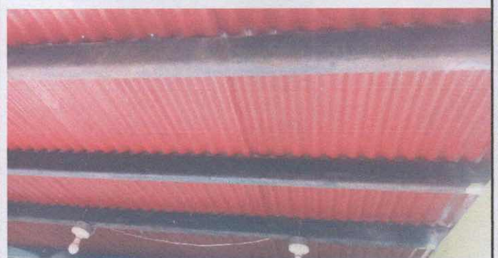
SUSTITUCIÓN Y CAMBIO DE TECHADO DE SANITARIO
