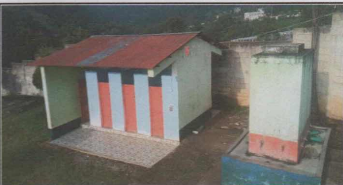
SUSTITUCIÓN Y CAMBIO DE TECHADO DE SANITARIO
