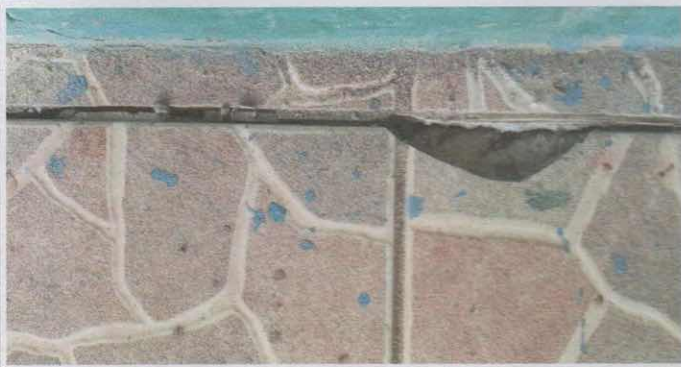
SUSTITUCIÓN DE PISO POR MAL ESTADO
