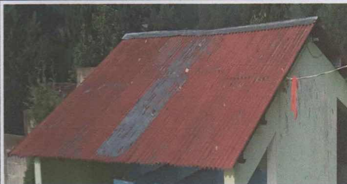
SUSTITUCIÓN Y CAMBIO DE TECHADO DE SANITARIO
