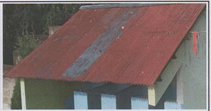
SUSTITUCIÓN Y CAMBIO DE TECHADO DE SANITARIO
