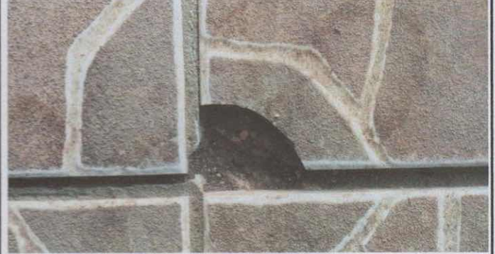
SUSTITUCIÓN DE PISO POR MAL ESTADO
