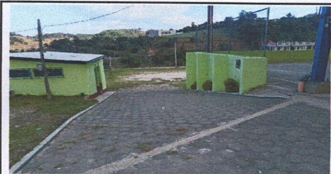
Colocación de porton en la entrada del establecimiento.
