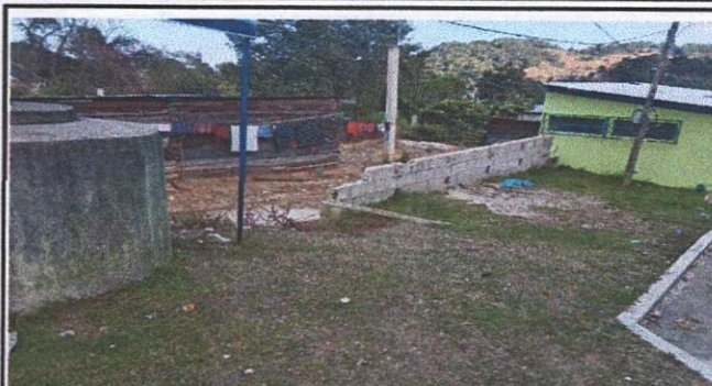
Ampliación del muro de circulación
