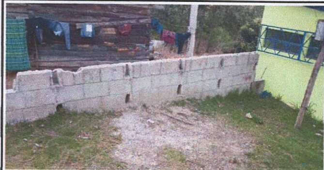
Reforzamiento de muro de contención y del muro de circulación
