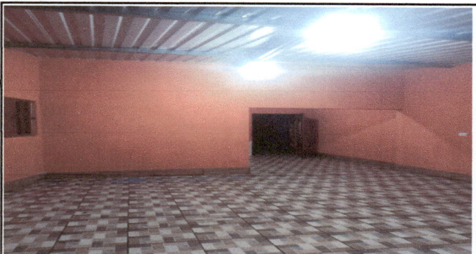
Reparación de pared en cocina 26 mts lineales.
