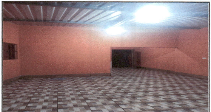
Cubierta de pintura en cocina 160 mts.2
