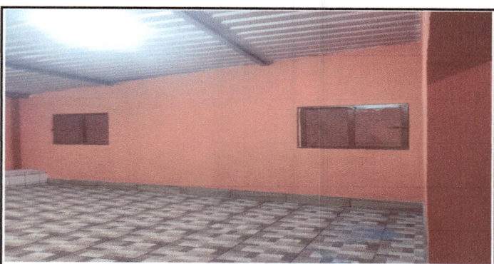
Sustitución de ventanas en cocina existentes.
