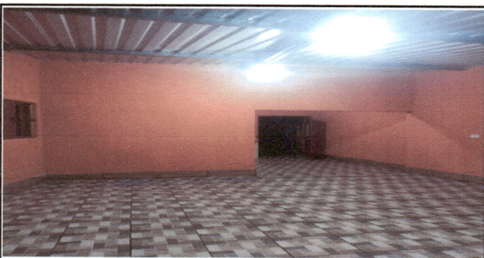
Repello gris y blanco en pared existente 97 mts 2 .
