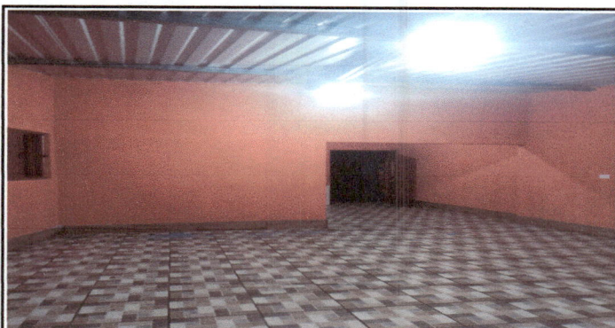
Instalación de piso ceramico en socalo 7 mts 2 para protección de humedad.
