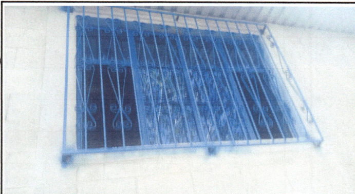
Instalación de balcones de seguridad en aulas.
