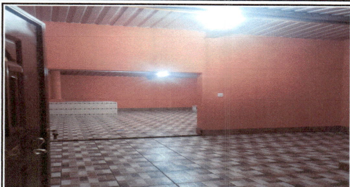
Levantado de pared 11 mts 2 para la ampliación de cocina, cernido gris y blanco, fundición de desayunador y azulejeado para servicio, cortina de metal y puerta de acceso.
