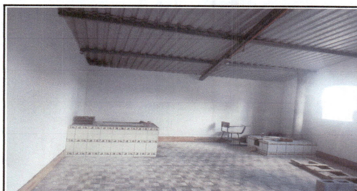
Instalación de piso ceramico en socalo 7 mts2 para protección de humedad.
