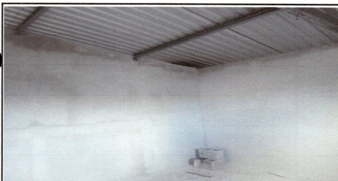
Reparación de pared en cocina 26 mts lineales.
