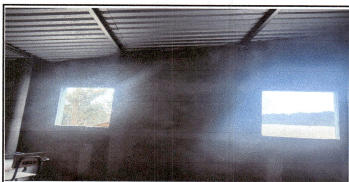
Sustitución de ventanas en cocina existentes.
