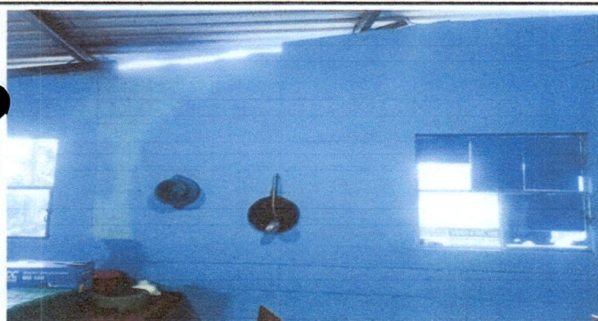
Reparación de pared en cocina 26 mts lineales.
