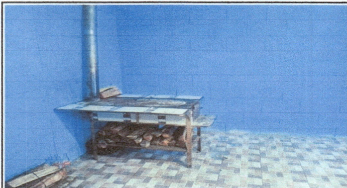
Construcción de una estufa de leña
