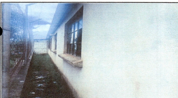
Instalación de balcones de seguridad en aulas.
