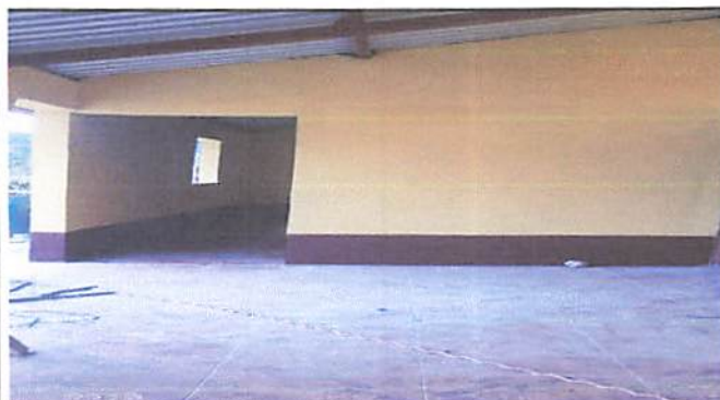
Foto 3: Levantamiento de pared para aula.
