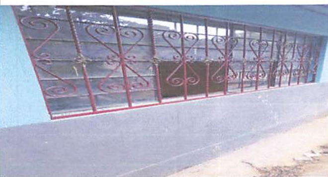
Foto 5: Instalación de balcones
