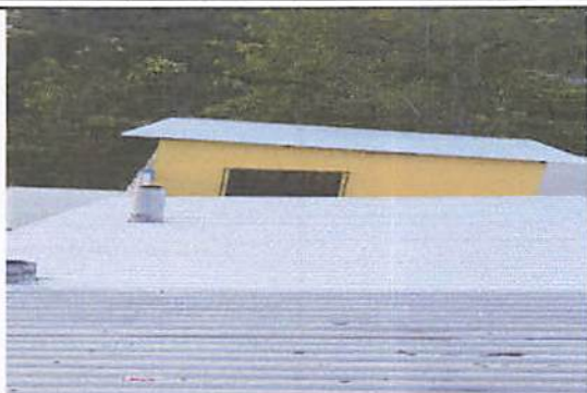
Foto 13: Sustitución e instalación de lámina troqueilada calibre 26
