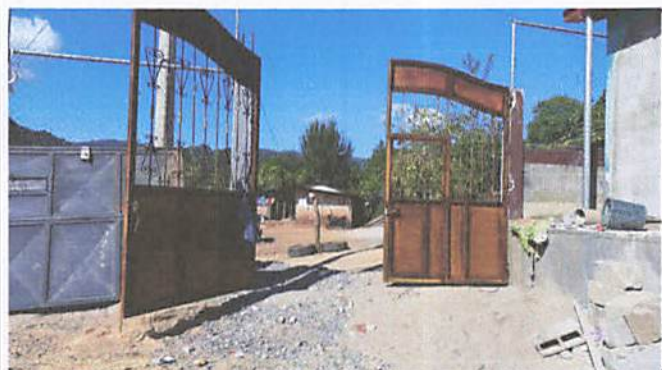
Foto 9: Sustitución e instalación de portón con techo incluido.
