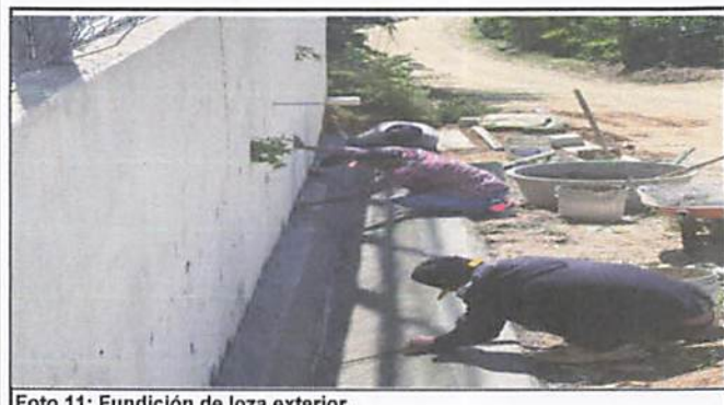
Foto 11: Fundición de loza exterior.
