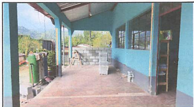
Foto 3: Levantamiento de pared para aula.
