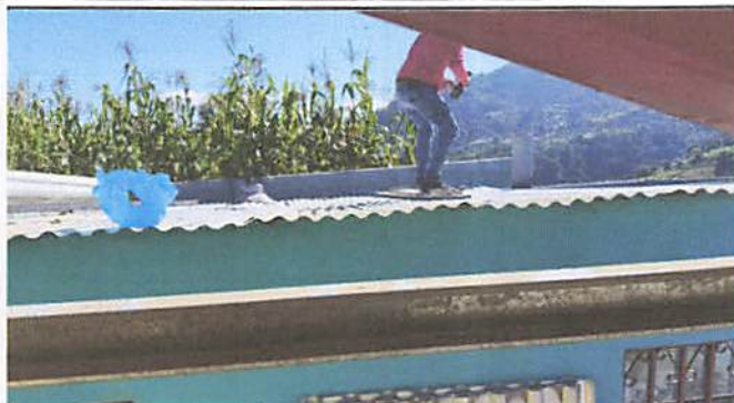
Foto 13: Sustitución e instalación de lamina troquela calibre 26
