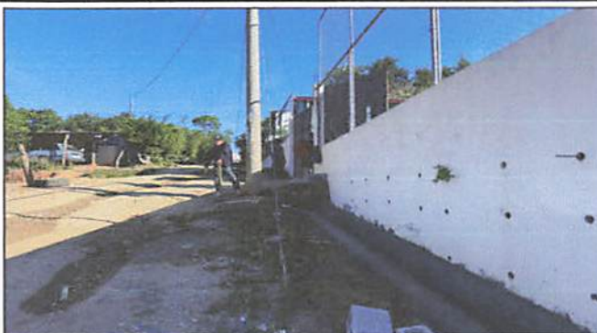
Foto 8: Elaboración de cuneta externa.
