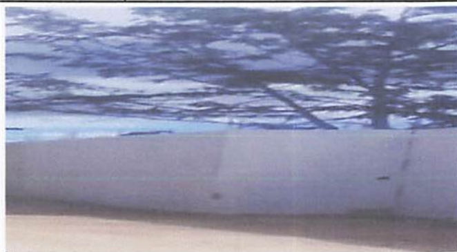
Foto 7: Pintura de muro perimetral
