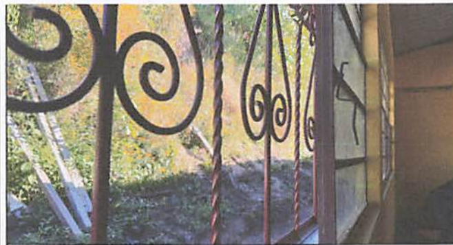
Foto 5: Instalación de balcones
