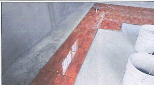
Foto 1: Instalación de piso antideslizante aula de primero primaria.
