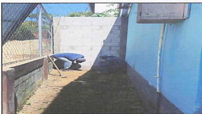
Foto 10: Levantamiento de pared y drenaje.
