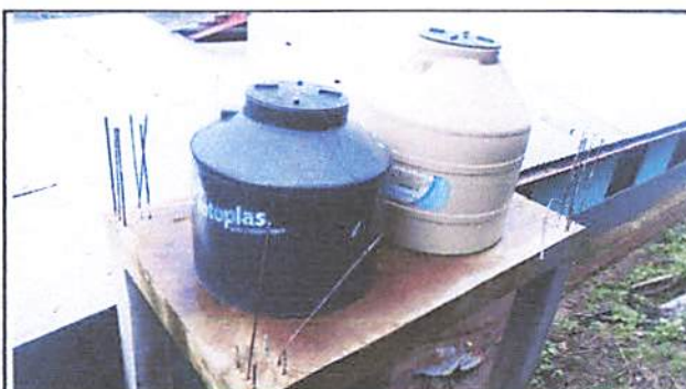
Foto 12: Camino de accesorios de baño y desposito de agua.
