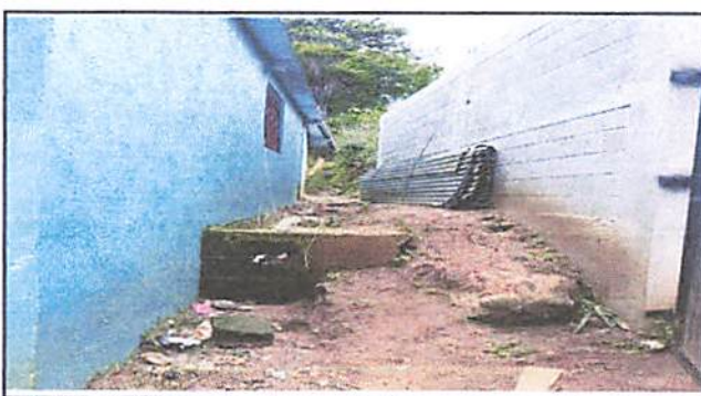
Foto 6: Conexión de tubos de agua pluvial.
