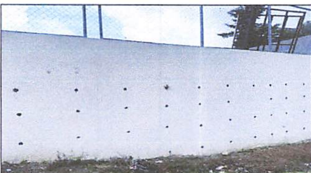
Foto 11: Fundición de loza exterior
