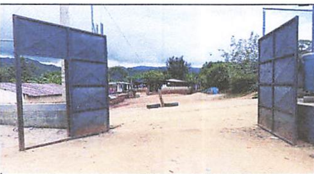
Foto 9: Sustitución y elaboración de portón con techo incluido.
