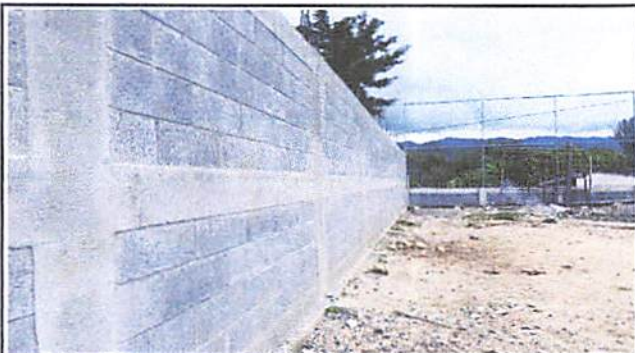
Foto 7: Pintura de muro perimetral
