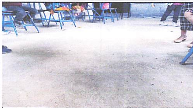
Foto1: Instalación de piso antideslizante en el aula de primero primaria.
