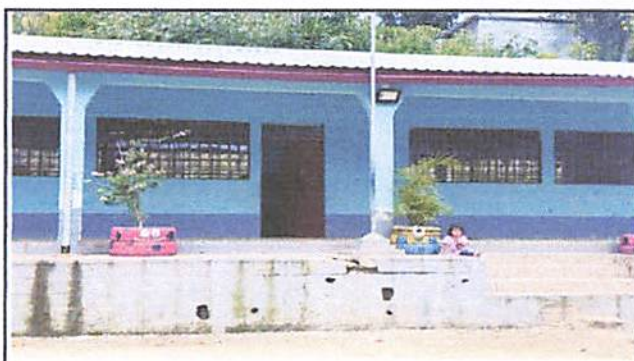
Foto 4: Pintura para todos los salones de clases interior y exterior.
