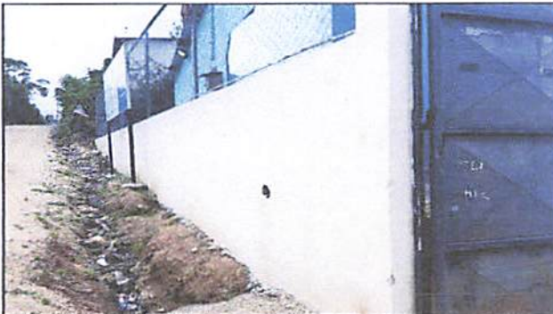
Foto 8: Elaboración de cuneta externa.
