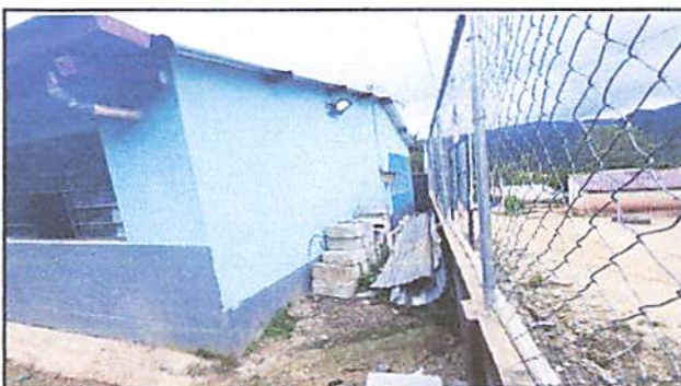
Foto 10: Levantamiento de pared e instalación de drenaje.
