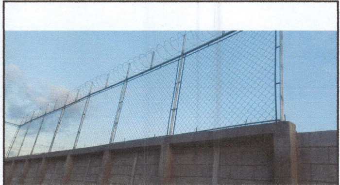
Malla instalada con tubos, planas y alambre de seguridad RAZOR
