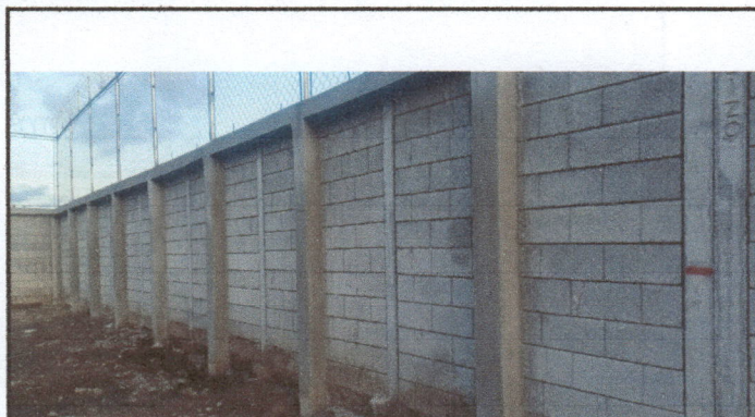
Seobserva otra de las areas remozadas terninadas con las columnas y solera final
