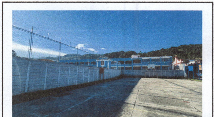
Se puede observar el trabajo terminado de malla y alambre de seguridad sobre el muro perimetral
