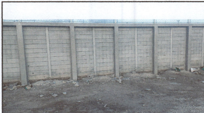
Se observa el trabajo finalde tallado de columnas y soleras
