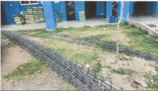
Armado de columnas
