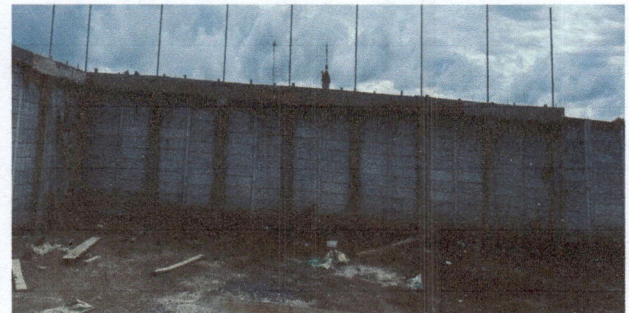
Fundido de solera
