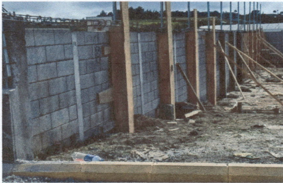
Formateado y fundido de columnas
