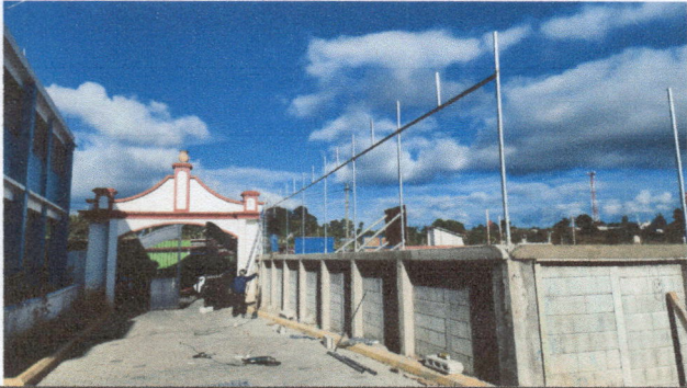
Foto 1: Inicio de trabajo para colocación de malla
