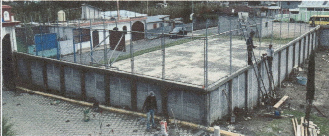
Foto 3: Avance en la colocación de malla
