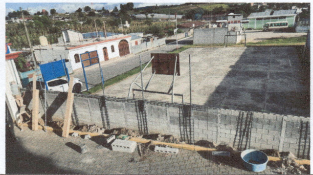
Armado y colocación de columnas y solera final
