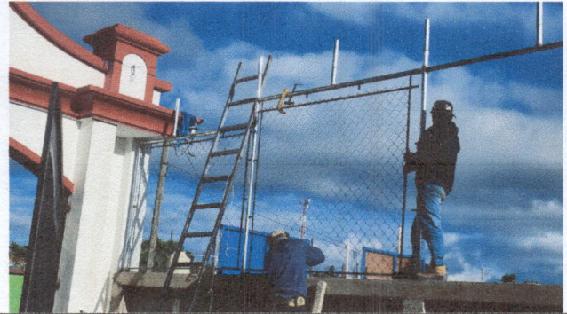
Foto 2: Colocación de planas y malla
