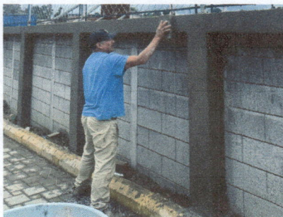
Tallado de columnas y solera final
