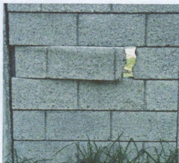
Cambio de placa tipo block, por deterioro
