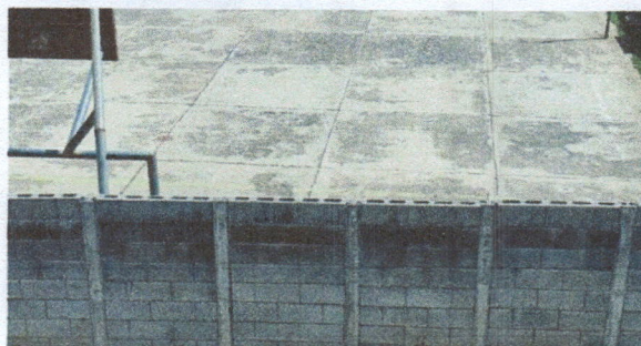
Fundición de solera final de amarre sobre muro perimetral, para asegurar y evitar el deterioro de la misma.
