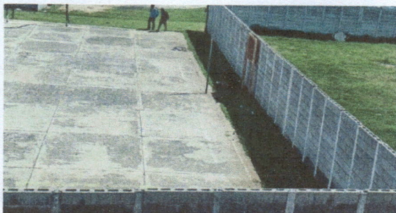
Colocación de malla sobre muro perimetral, para evitar el ingreso de personas ajenas al establecimiento.
