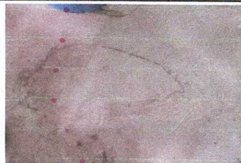
Foto 6: la imagen evidencia las rajaduras del suelo
