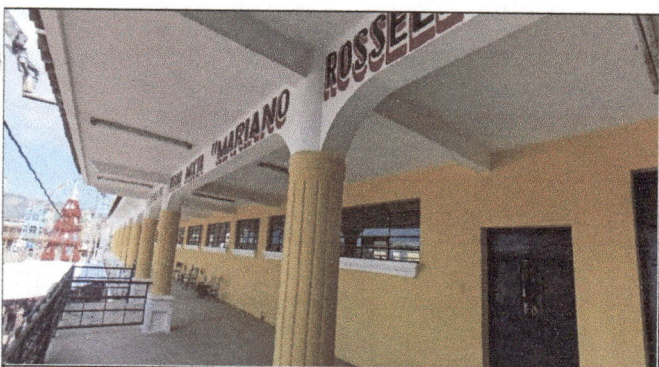
Foto 15: Pintado de corredores, pilares y y techo en la parte de enfrente del segundo nivel de la escuela.
