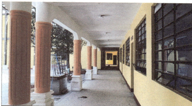
Foto 13: Pintado de exteriores, corredores del primer nivel.
