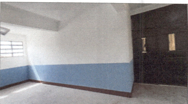
Foto 18: Pintado del salón de Usos Múltiples, dos direcciones, bodegas y baños. En sí, se pintó toda la escuela.
