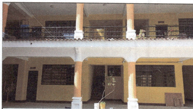
Foto 14: Pintado de exteriores en corredores, pilares, techo y sáculo en primero y segundo niveles.
