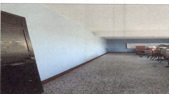
Foto 12: Aula interior pintado, faltándole algunos mínimos detalles del pintado del techo.
