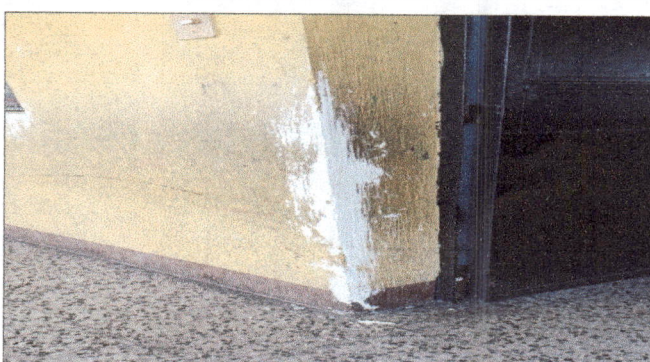
Foto 10: Culminacion de reparacion de esquinas interiores de salones de clase y ambientes escolares en su totalidad.
