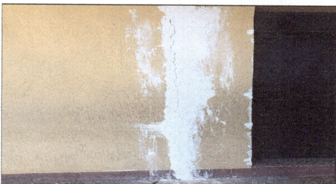
Foto 9: Reparación de fisuras interiores y exteriores previos al inicio de pinturas en interiores y exteriores.
