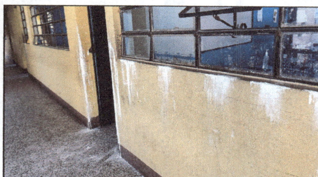
Foto 8: Reparación de orillas lastimadas de todos los salones de clase y ambientes escolares en interiores y exteriores.
