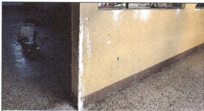
Foto 7: Inicio en reparacion de esquinas exteriores.
