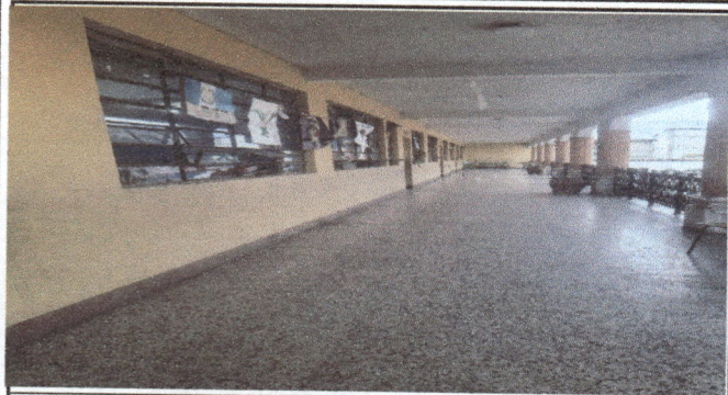
Foto 1. Pintura en muros exteriores e interiores en edificio escolar.
