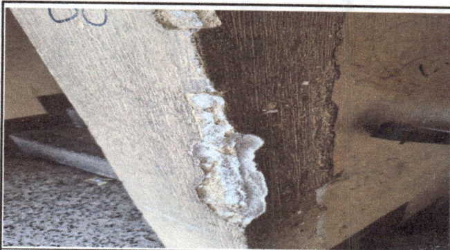
Foto 4. Reparación de esquina de paredes dañadas.
