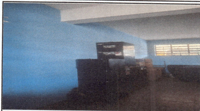
Foto 2. Pintura en muros exteriores e interiores en edificio escolar.
