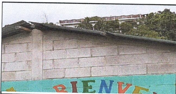
Foto 5: Cambio de laminas deteriorado de cocina
