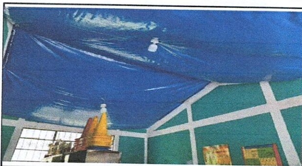
Foto 3: Para mejor presentacion cambio de nylon a cielo falso, de las 3 aulas y direccion.
