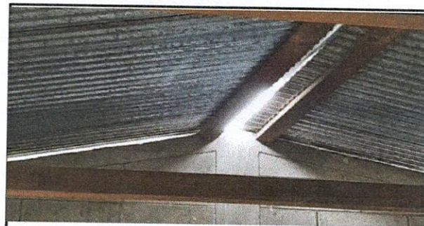
Foto 6: Laminas en mal estado de cocina y corredor
