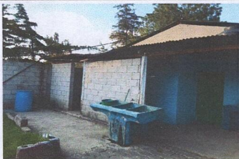
Foto1: Vista principal de los baños
