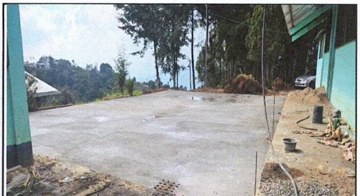
Foto 4: LOSA DE PATIO: ELABORACIÓN DE PLANCHAS DE CONCRETO
