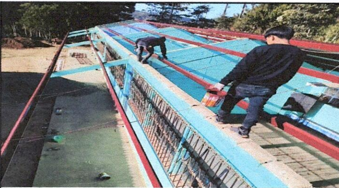
Foto 3: PINTURA A ESTRUCTURA DE SOPORTE DE METAL
