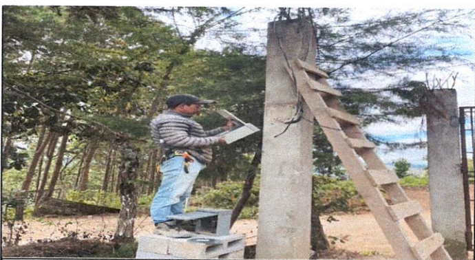
Foto 6: SUSTITUCIÓN DE TABLERO FLIPONES
