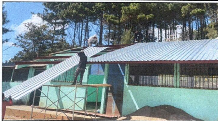
Foto1: SUSTITUCIÓN DE LÁMINA DEL TECHO
