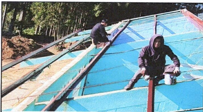
Foto 3: PINTURA A ESTRUCTURA DE SOPORTE DE METAL
