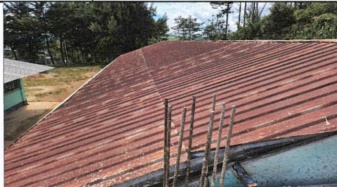
Foto 1: SUSTITUCIÓN DE LÁMINA DEL TECHO
