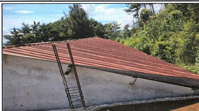
Foto 2: SUSTITUCIÓN DE LÁMINA DEL TECHO.
