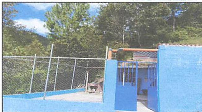
Foto 2: Muro perimetral a remozar.
