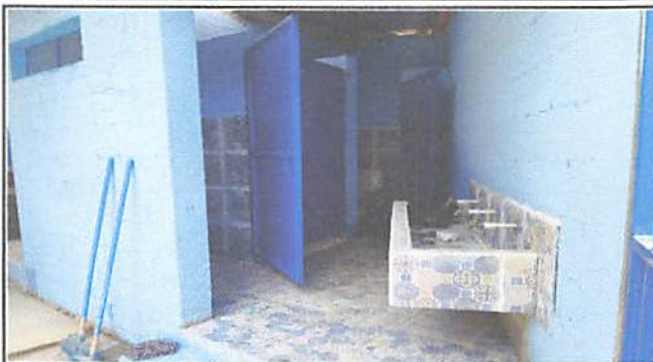
Foto1: Area de servicios sanitarios a remozar.
