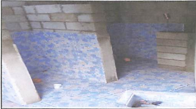
Foto 1: Area de servicios sanitarios a remozar.
