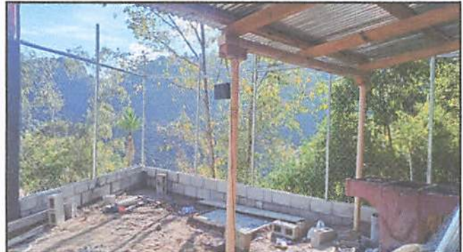
Foto 2: Muro perimetral a remozar.
