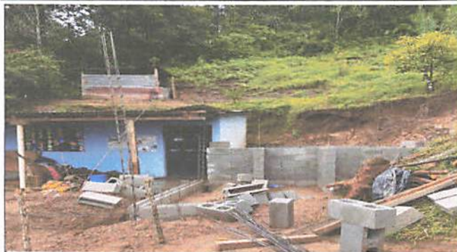
Foto1: Area de servicios sanitarios a remozar.
