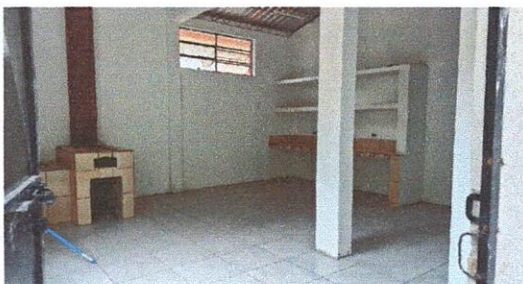
Foto 3: ampliación de cocina, cosntrucción, tallado e instalación gabinetes aéreo y de piso
