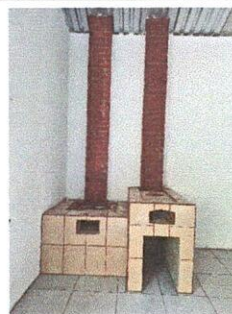
Foto 2: sustitución de chimenea de ladrillo, tallado e instalacion de azulejo en poyo de cocina, instalacion de poyo de cocina.
