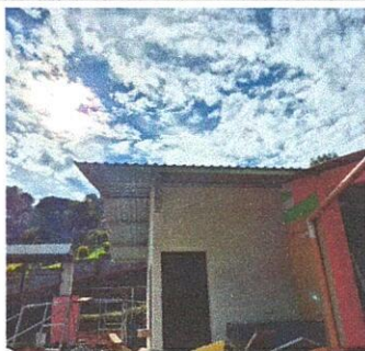
Foto1: Levantada de pared de cocina, añadir columnas hasta el nivel de los salones.
