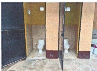
Foto 5: sustitución e instalación de sanitarios
