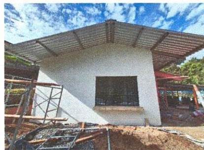
Foto 4: fundición e instalacion de piso en el la ventana del servicio de alientación, elaboración e instalacion de ventana y rejas corridizas para la ventana.
