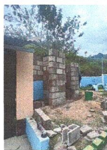
Foto 6: Levantado de pared, repello y cernido, instalación de azulejos y piso antideslizante
