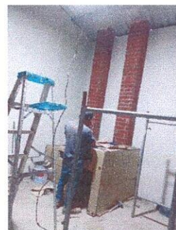
Foto 2: sustitución de chimenea de ladrillo, tallado e instalacion de azulejo en poyo de cocina, instalacion de pollo de cocina.
