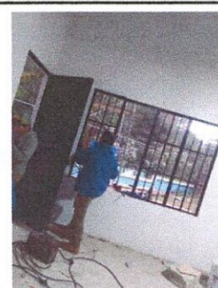
Foto 4: fundición e instalacion de piso en el la ventana del servicio de alientación, elaboración e instalacion de ventana y rejas corridizas para la ventana.
