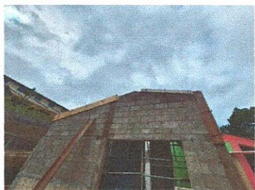
Foto1: Levantada de pared de cocina, añadir columnas hasta el nivel de los salones.
