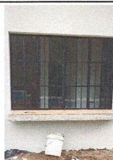
Foto 4: fundición e instalacion de piso en el la ventana del servicio de alientación, elaboración e instalacion de ventana y rejas corridizas para la ventana.
