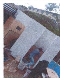
Foto 6: Levantado de pared, repello y cernido, instalación de azulejos y piso antideslizante
