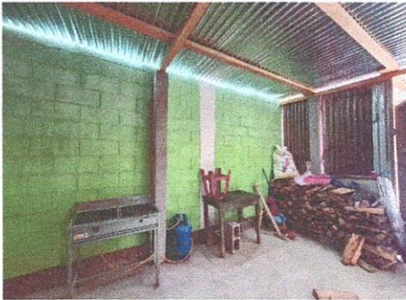
Foto 3: ampliación de cocina, cosntrucción, tallado e instalación gabinetes aéreo y de piso
