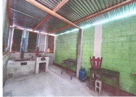
Foto 2: sustitución de chimenea de ladrillo, tallado e instalacion de azulejo en poyo de cocina, instalacion de pollo de cocina.
