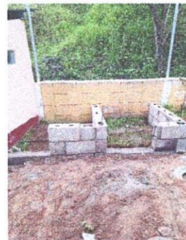
Foto 6: Levantado de pared, repello y cernido, instalaci3n de azulejos y piso antideslizante e instalacion de sanitario.
