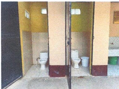
Foto 5: sustitución e instalación de sanitarios
