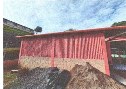
Foto 4: fundición de desayunoador e instalacion de piso en el desayunoador, elaboraci3n e instalacion de ventana y rejas corredizas para la ventana.
