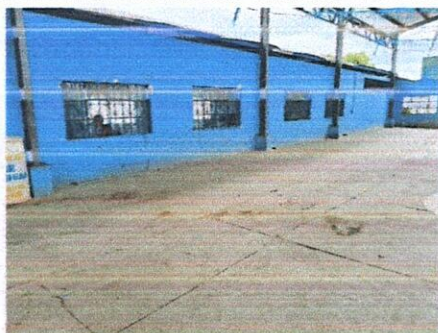
Foto 3: Reparación de banquetas de block.
