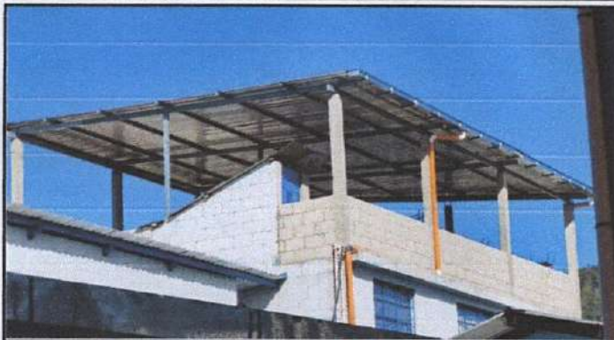
Foto 1: Levantado de muro de salón a remozar.
