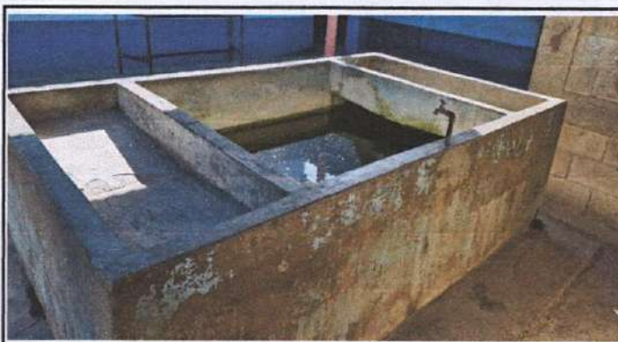
Foto 4: Pila a remozar
