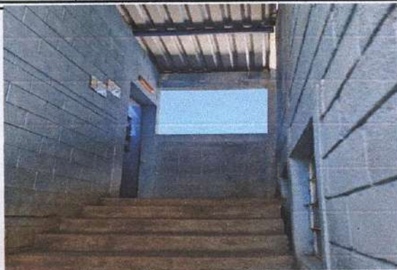
Foto7: Espacio de ventana a remozar
