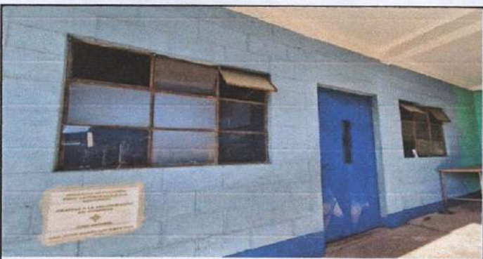
Foto 5: Dos ventanas en área de cocina a remozar
