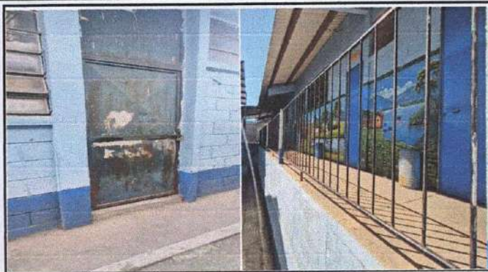
Foto 8: Remozamiento de puertas, portones y baranda
