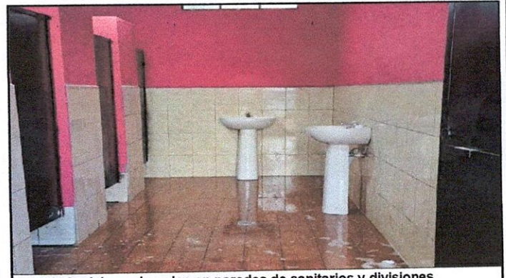
Foto 4: Azulejos colocados en paredes de sanitarios y divisiones.
