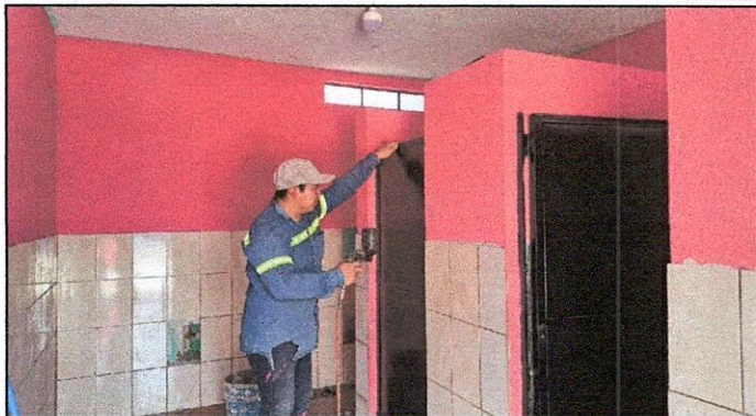
Foto 7: Cambio e instalación de puertas de metal.
