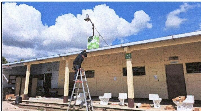
Foto 10: Colocación de canales de bajada de agua.
