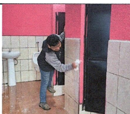
Foto 6: Colocación de puerta de metal de entrada sanitarios.
