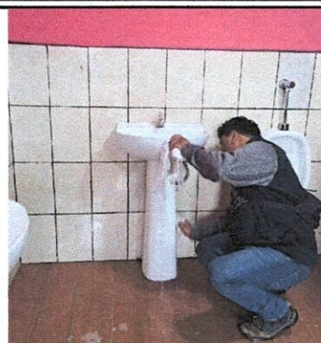
Foto 2: Colocación de nuevos lavamanos.
