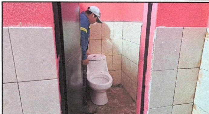
Foto1: Sustitución de sanitarios.
