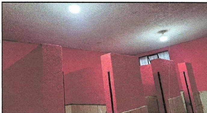
Foto 9: Sistema eléctrico reparado.
