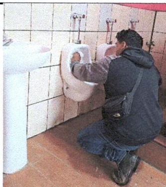
Foto 3: Colocación de nuevos mingitorios.
