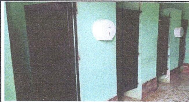
Foto 7: PUERTAS DE METAL SANITARIOS INDIVIDUALES
