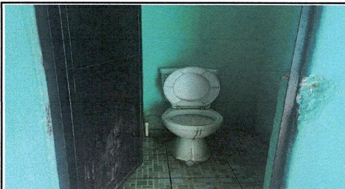
Foto1: CAMBIO DE SANITARIOS.
