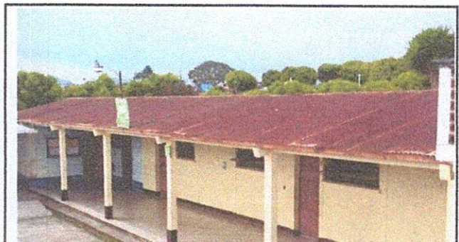
Foto 10: CANALES Y BAJADA DE AGUA
