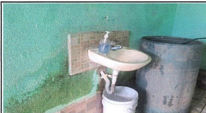
Foto 2: CAMBIO DE LAVAMANOS
