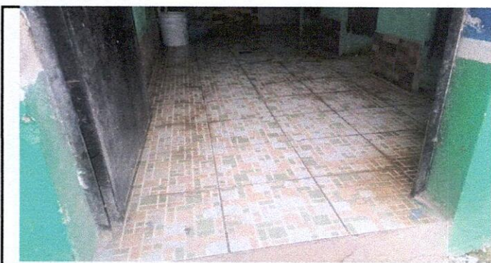
Foto 5: SUSTITUCION DE PISO DE SERVICIOS SANITARIOS
