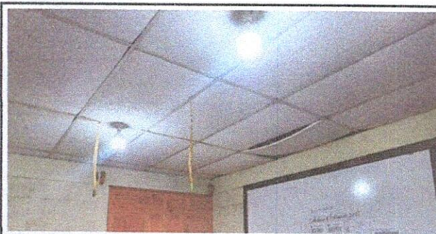
Foto 11: INSTALACIÓN DE CIELO FALSO DE PVC SALA DE PROFESORES
