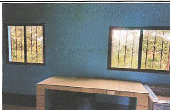
Foto 2: Sustitución de estructura de metal de ventana por aluminio.
