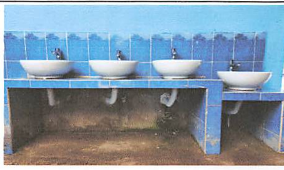
Foto 12: Reparación de lavamanos.
