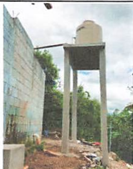
Foto 11: Sustitución de depósito de agua 1100 litros.
