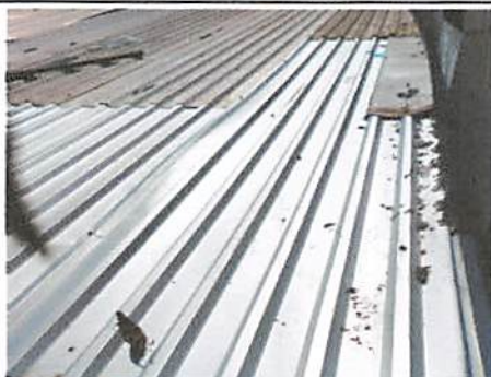
Foto 9: Sustitución de techo por lámina troquelada calibre 26.
