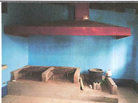
Foto 1: Mantenimiento a estufa rural.
