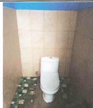
Foto 8: Sustitución e instalación de inodoro.
