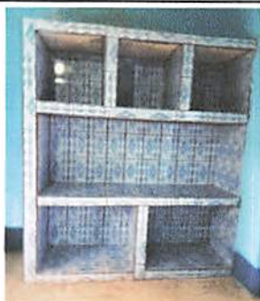
Foto 5: Reparación de azulejos en muebles de cocina.
