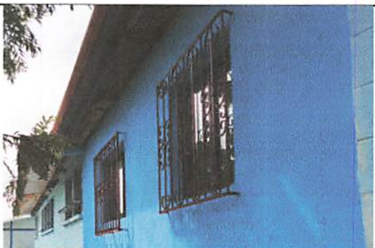
Foto 3: Fabricación e instalación de balcones de hierro en ventanas para cocina.
