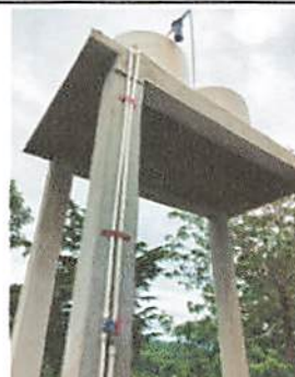
Foto 10: Fabricación de base de 2 tinacos.
