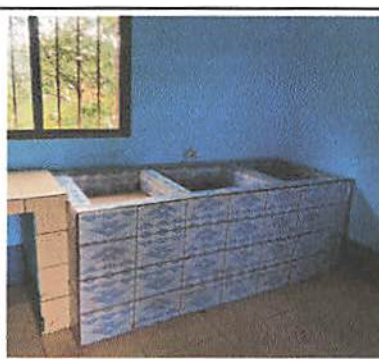
Foto 4: Sustitución de pila de cemento de 2 lavadero por una pila de concreto.
