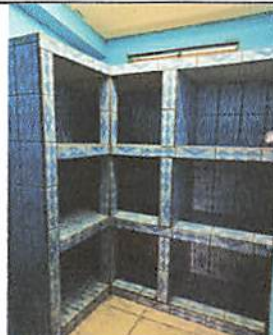
Foto 6: Fabricación de estantería de concreto de 3 gradas.
