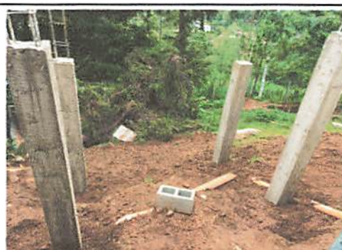
Foto 10: Fabricación de base de 2 tinacos.
