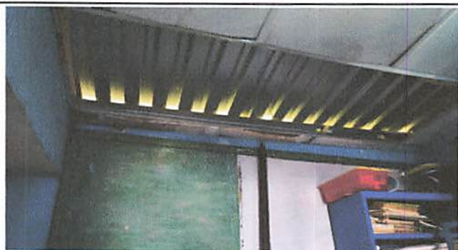
Foto 9: Sustitución de techo por lámina troquelada calibre 26.
