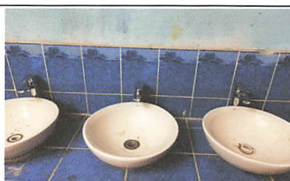
Foto 12: Reparación de lavamanos.
