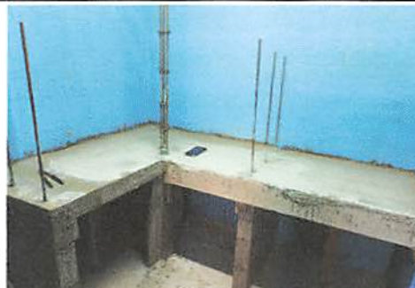
Foto 6: Fabricación de estantería de concreto de 3 gradas.
