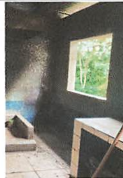
Foto 2: Sustitución de estructura de metal de ventana por aluminio.
