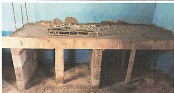
Foto 5: Reparación de azulejos en muebles de cocina.
