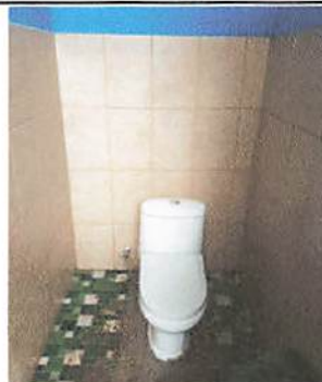
Foto 8: Sustitución e instalación de inodoro.
